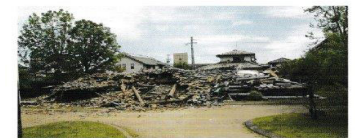
平成28年熊本大地震で倒壊した熊本洋学校教師ジェーンズ邸
